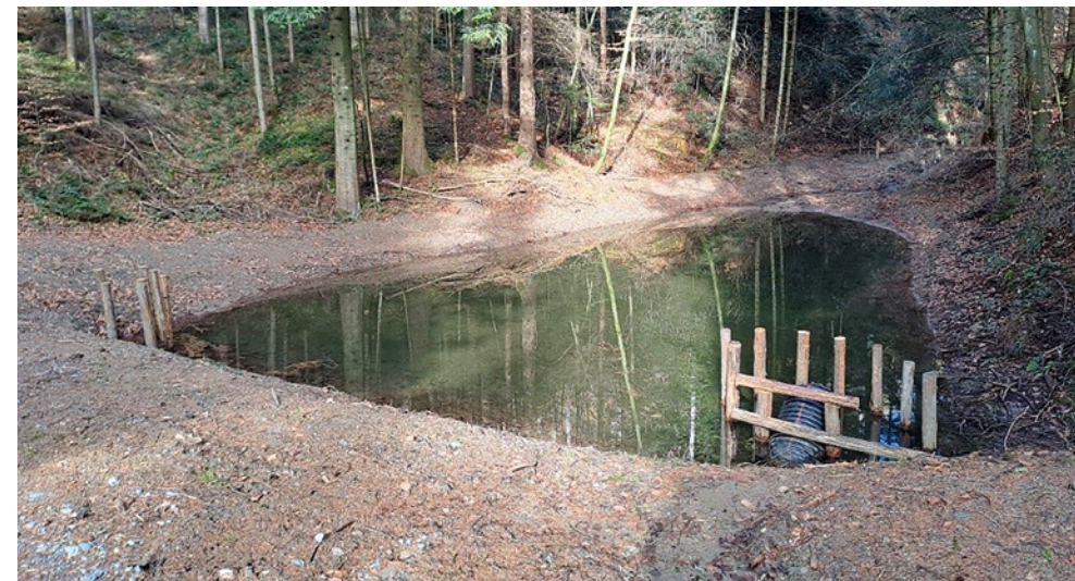
Retentionsbecken im Bereich einer Grabenquerung zur Verbesserung des Wasserhaus- haltes und Förderung der Biodiversität
